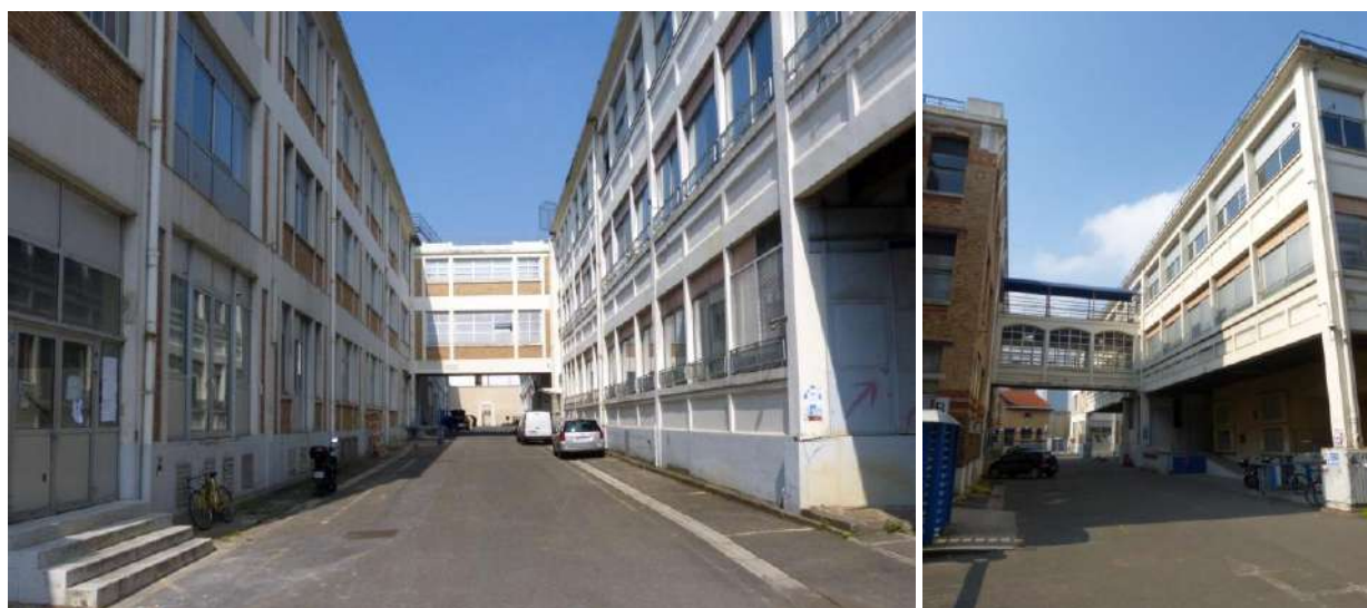
Gauche : Passerelle reliant le magasin central (droite) à la savonnerie (gauche). - Droite : passerelle raccordant le bâtiment administratif (gauche) au magasin central (droite).
