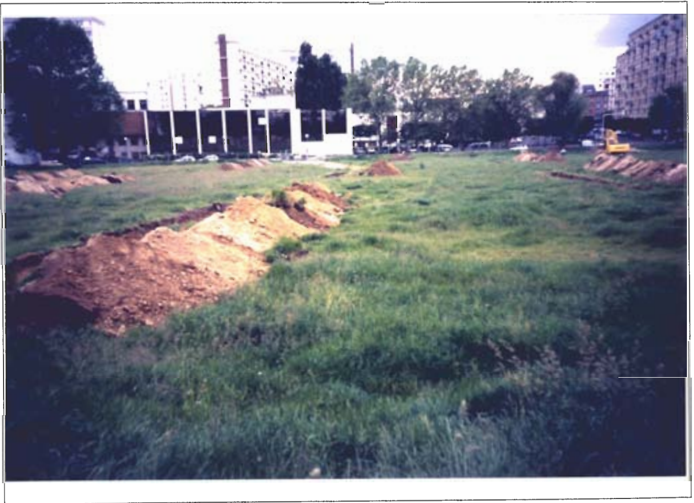
Fig. 8 Vue d'une partie du chantier avec des tranchées. Cl. C.G.
