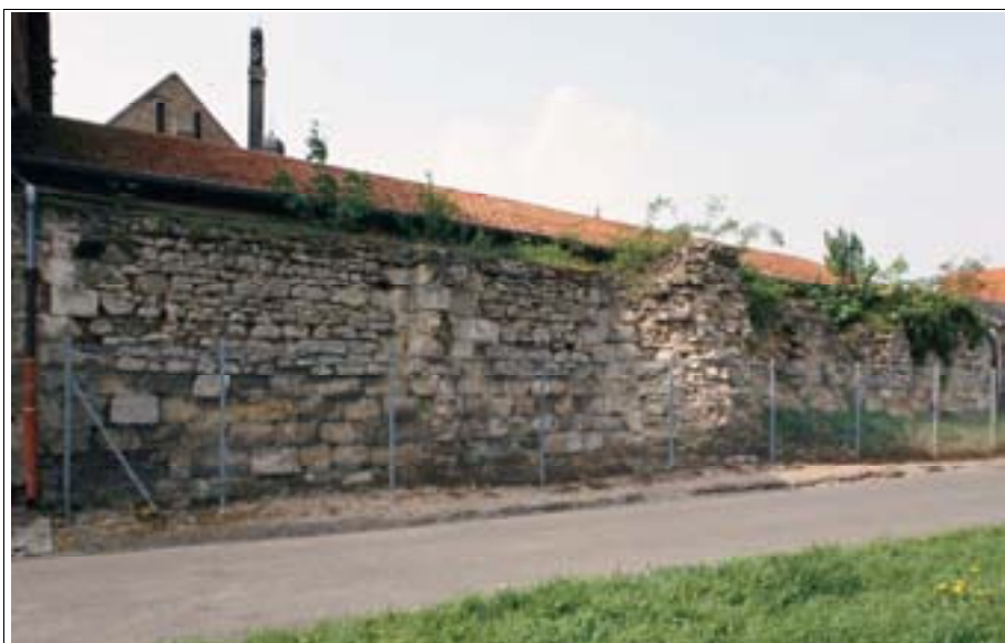
Fig. 6 Vestiges de l'enceinte médiévale, rue des Fossés
