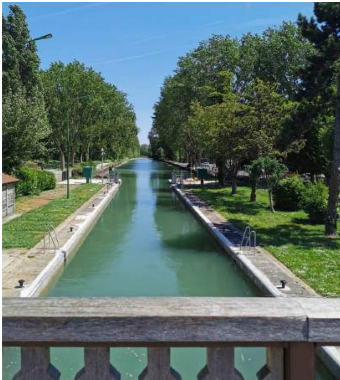
Le canal de Chelles, qui relie Neuilly-sur-Marne à Vaires-sur-Marne. Il est creusé entre 1848 et 1862. Photographies Charlotte Mus et Julien Fontaine
