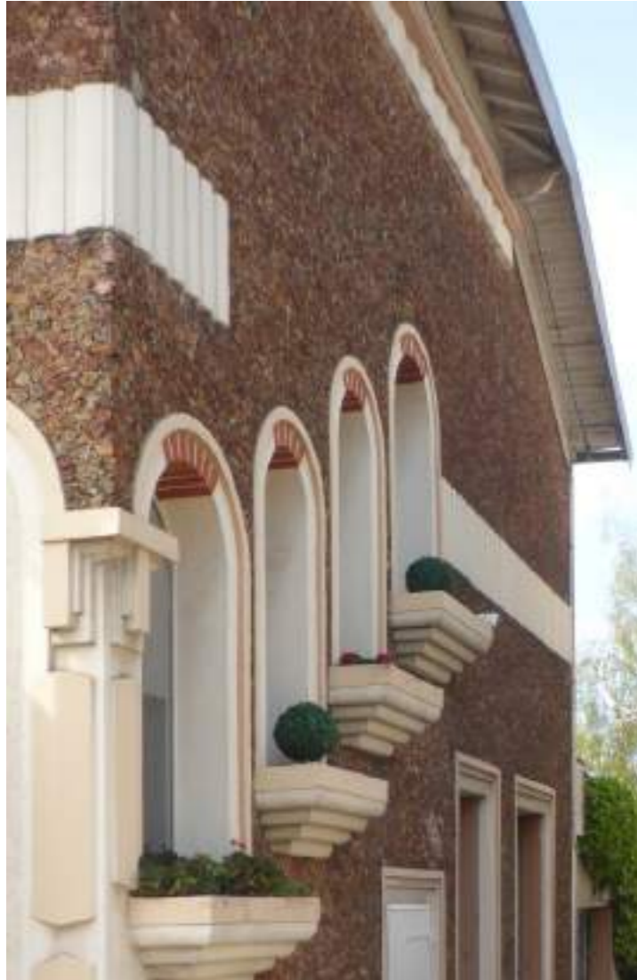
Baies et jardinières sur la façade latérale de la maison, 1 quater rue du Général Schmitz, architecte non identifié. Photographie Hélène Caroux
