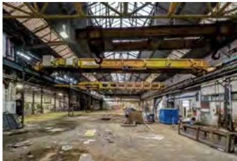
Intérieur de la halle du site Jules-Auffret. Une structure en acier surmontée de celle du pont roulant et du ferroutin, qui finalement ne sera pas installé en bois.
