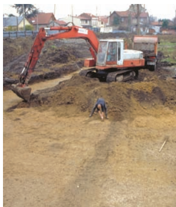
2. Décapage du terrain permettant la fouille, rue Charles-Gide
