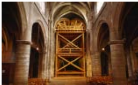
11. Etaielement destiné à soutenir les voûtes du chœur
