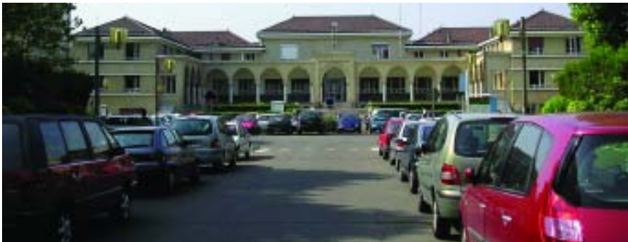
8. Perron d'honneur et colonnade, face à l'allée centrale.
