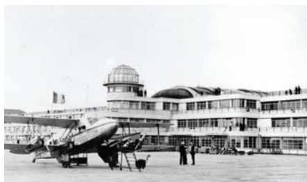
3. La tour de contrôle et l'avant-corps de l'aérogare du Bourget, 1939
