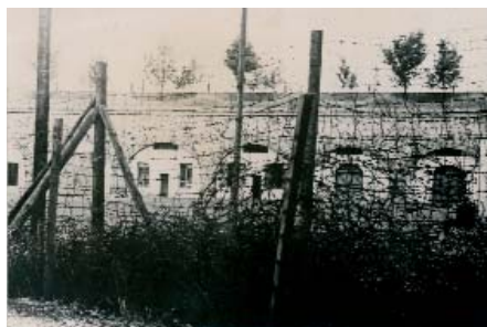
12. Casemates et barbelés entourant la cour du fort
