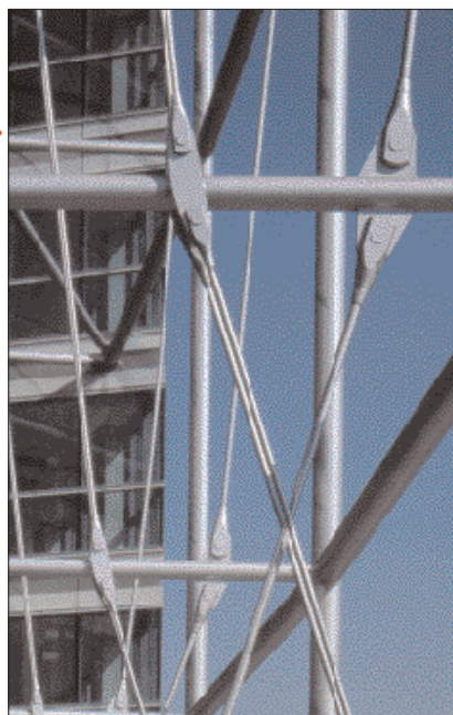
Détail structure métallique.
