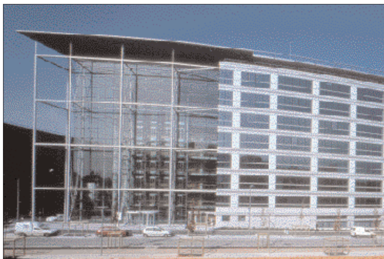
Vue générale, côté rue Touzet Gaillard.
