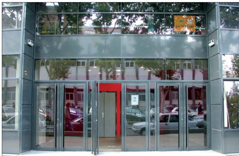
Entrée de l'immeuble.
