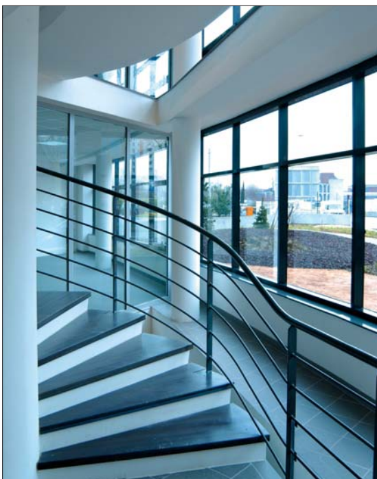
Structure en béton et menuiseries en aluminium.
